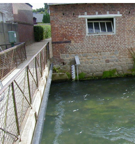
Station d'hydrométrie sur la Durdent à Vittefleur source : DREAL Normandie
