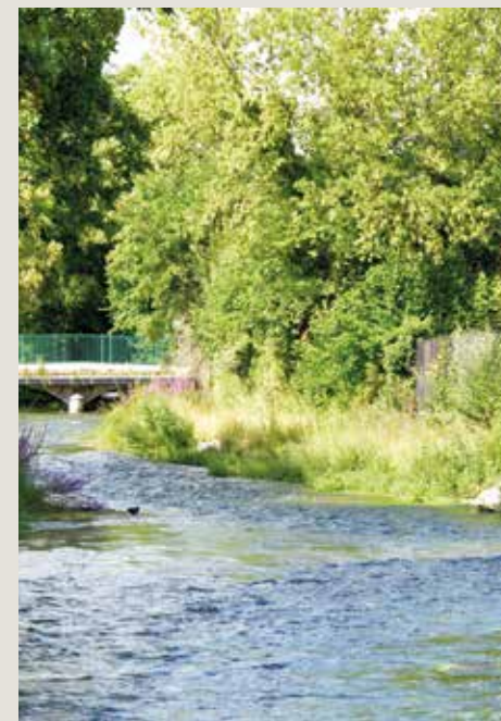
La continuité écologique du Cailly restaurée au niveau du vieux moulin Pellerin
