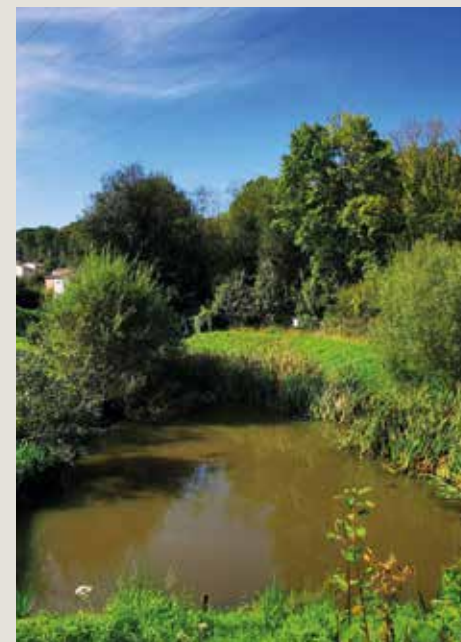
Bassin de rétention - Hameau de Frévaux
